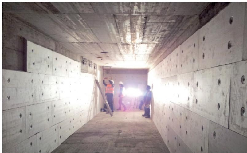
Vista interna della vasca di restituzione dell'acqua alla falda, durante i lavori di costruzione: l'invaso (107 m<sup>3</sup>) ha lo scopo di ricevere l'acqua in uscita dagli scambiatori di calore ed equilibrare la portata al pozzo (Proeco).
