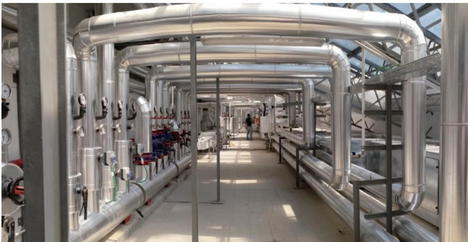
Molte delle u.t.a. sono distribuite nei sottotetti: anche a causa dei vincoli esistenti sull'edificio, alcune delle prese d'aria e delle estrazioni sono state delocalizzate rispetto alla posizione delle macchine (Proeco).
