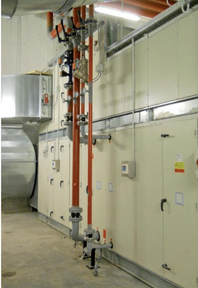
Per effetto della posizione delle centrali tecniche e della disponibilità di un unico punto di immissione, l'impianto di ventilazione è attestato su quattro u.t.a. per il pre-trattamento dell'aria (LC Progetti).
