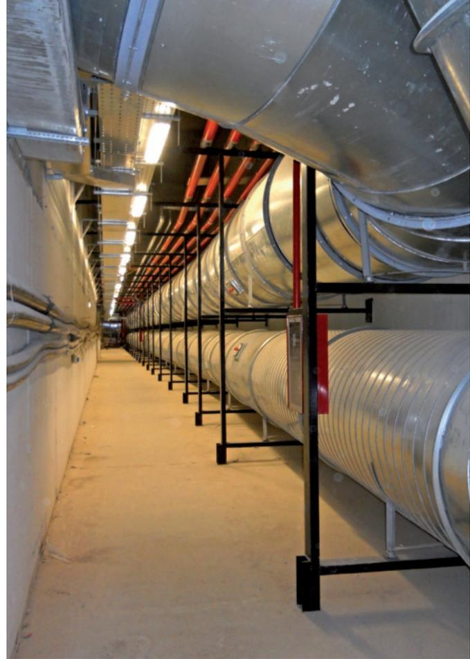
I cunicoli tecnologici cingono il piano interrato su tre lati: l'uso di condotte a spirale di distribuzione aerea è dovuto anche alla loro ridotta produzione di vibrazioni alle basse frequenze (LC Progetti).
