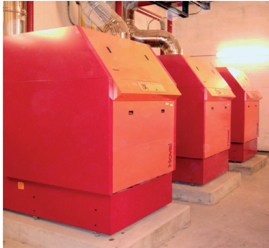
**Oltre alle caldaie a condensazione (circa 1.000 kW ciascuna), la centrale termica è predisposta per la futura integrazione con il campo solare termico con collettori a tubi sottovuoto per il solar cooling (LC Progetti).**
