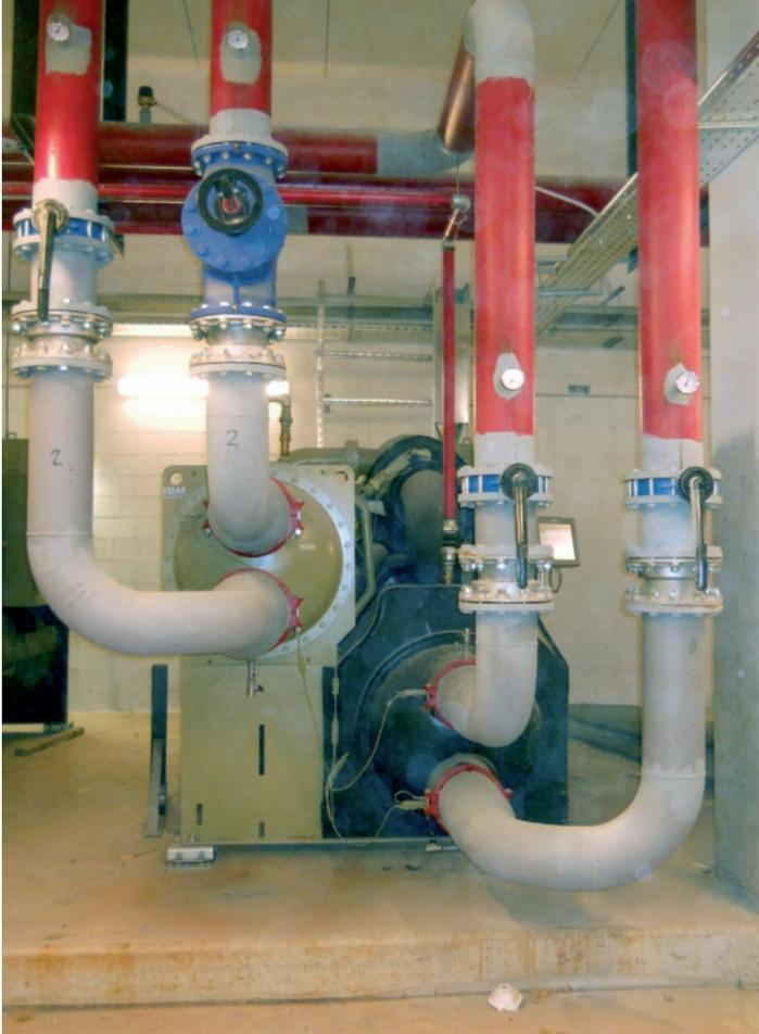
**Tre gruppi frigoriferi da 1.500 kW ciascuno provvedono alla produzione dell'acqua refrigerata a  $12 \pm 7$  °C; la dispersione del calore avviene mediante altrettante torri di evaporazione poste in copertura (LC Progetti).**
